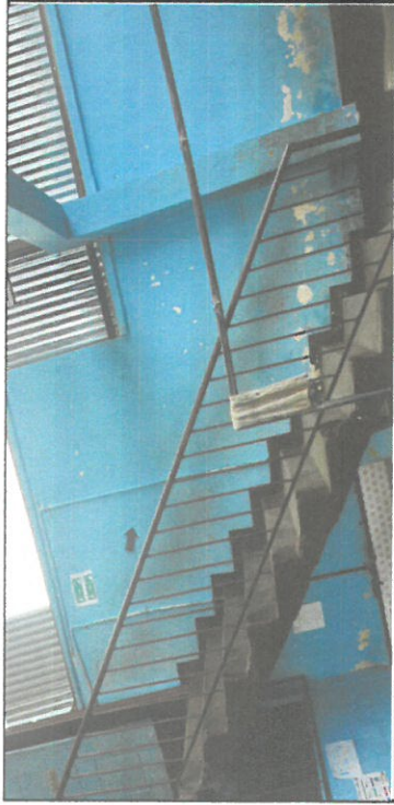
Foto 3. Pintada de baranda de gradas hacia segundo nivel
